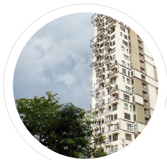
برج های مسکونی ونوس
