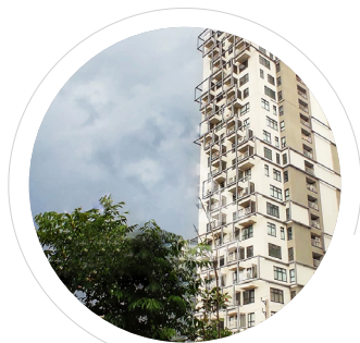
برج های مسکونی ونوس
