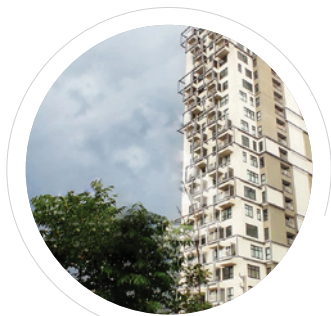
برج های مسکونی ونوس
